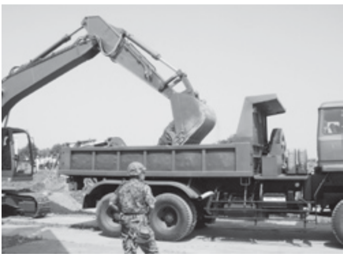
自衛隊による道路復旧訓練
