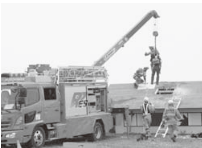
倒壊した家屋からの救出訓練
