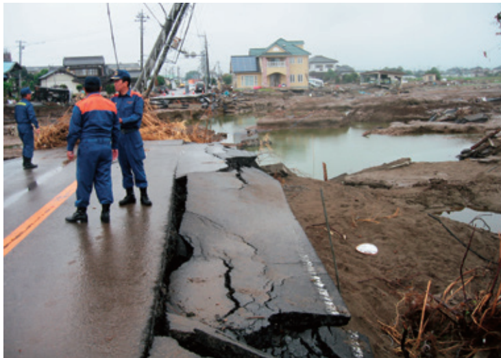
鬼怒川決壊箇所付近
