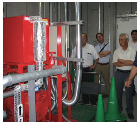
防火設備視察
