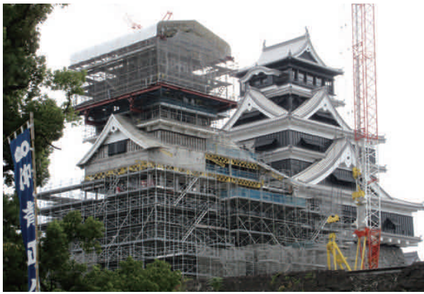
修復作業中の熊本城
