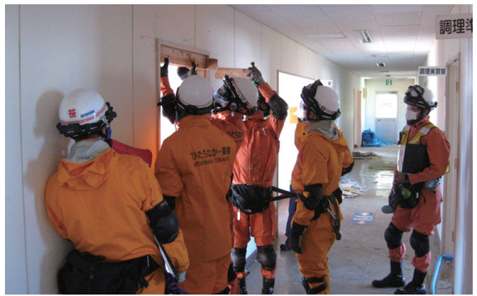
ショアリング訓練(開口部にショアリングを施してドアの枠を補強)
