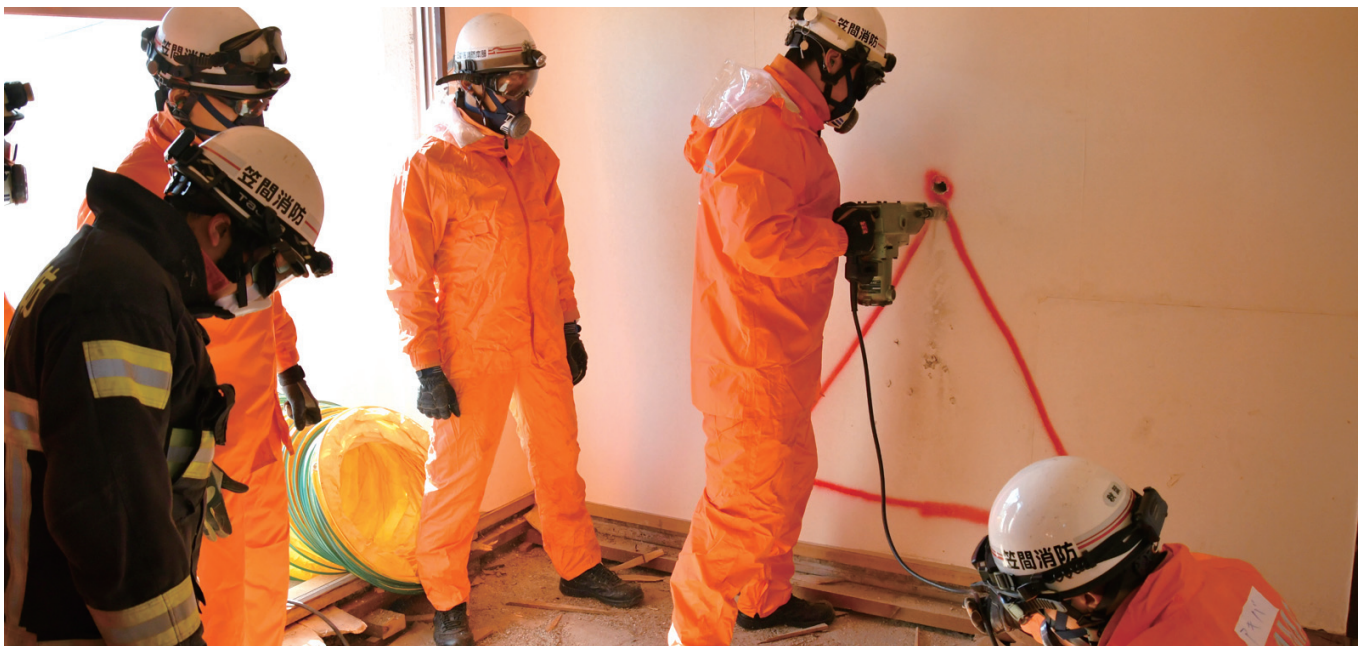
壁のはつり作業
